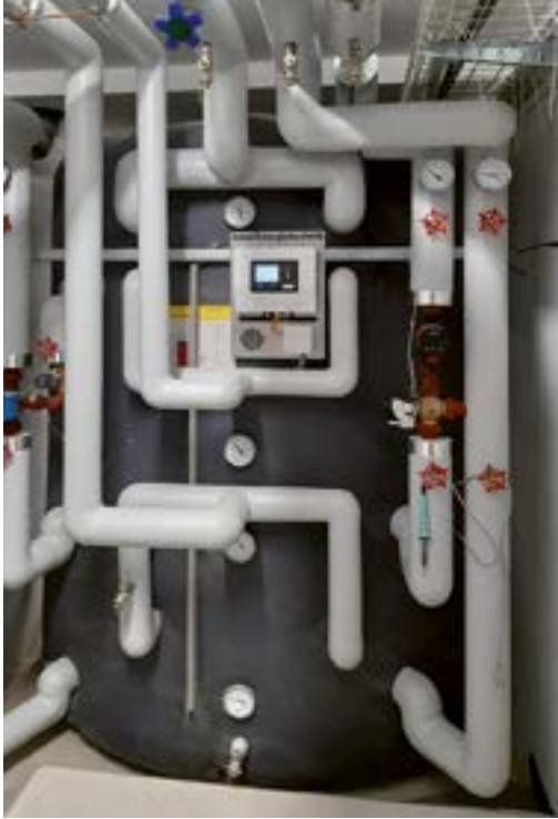
Laufend weiterentwickelt: thermische Energiespeicher von 600 bis 300 000 Liter, hergestellt im Emmental.
