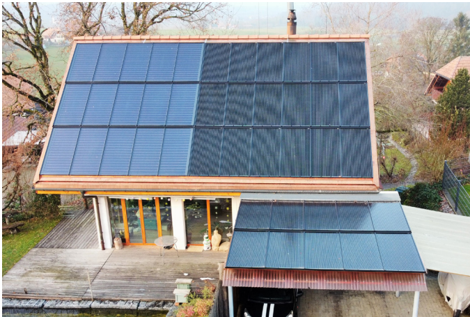
Autounterstand und Dach, Biezwil, Kombination mit Solarwärme
