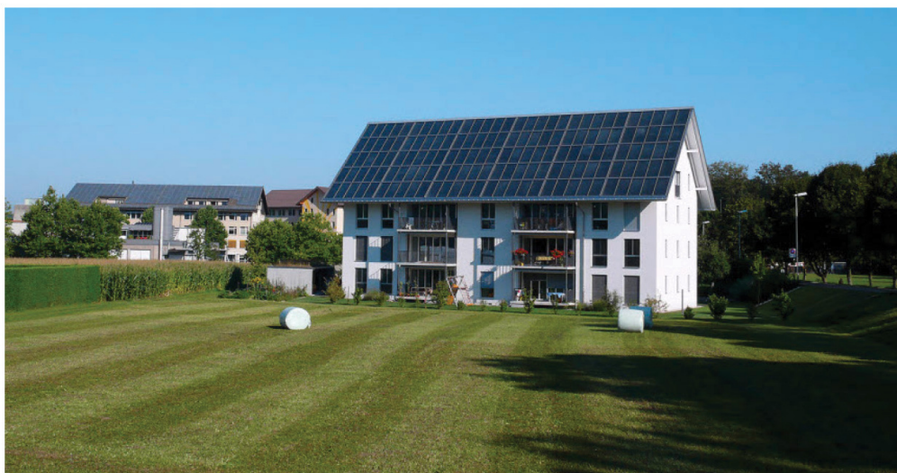
Auf der Matte beim ersten Sonnen-Mehrfamilienhaus sollen zwei ähnliche Gebäude entstehen.
