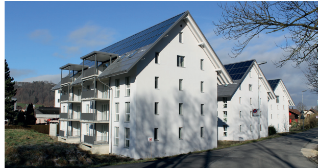
Unsere drei ersten vollständig solar beheizten Mehrfamilienhäuser - weitere Projekte sind vorhanden.
