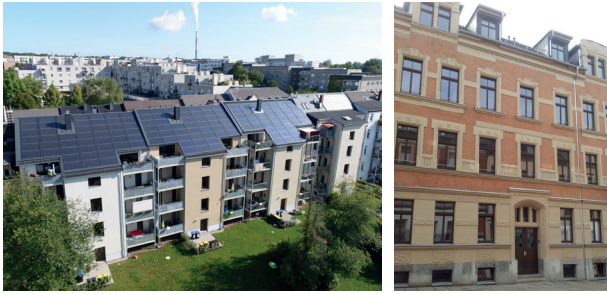
Solarsanierte Mehrfamilienhäuser von 1910 in Chemnitz Süd- resp. Nordfassade
