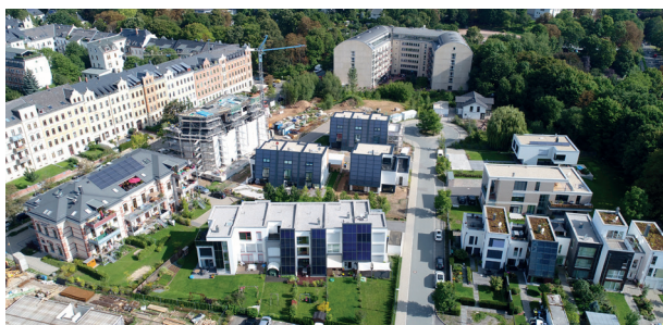
Solarüberbauung Salzstrasse in Chemnitz
