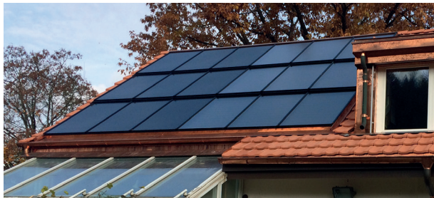
Energiedach mit Photovoltaik-Modulen (links) und thermischen Kollektoren
