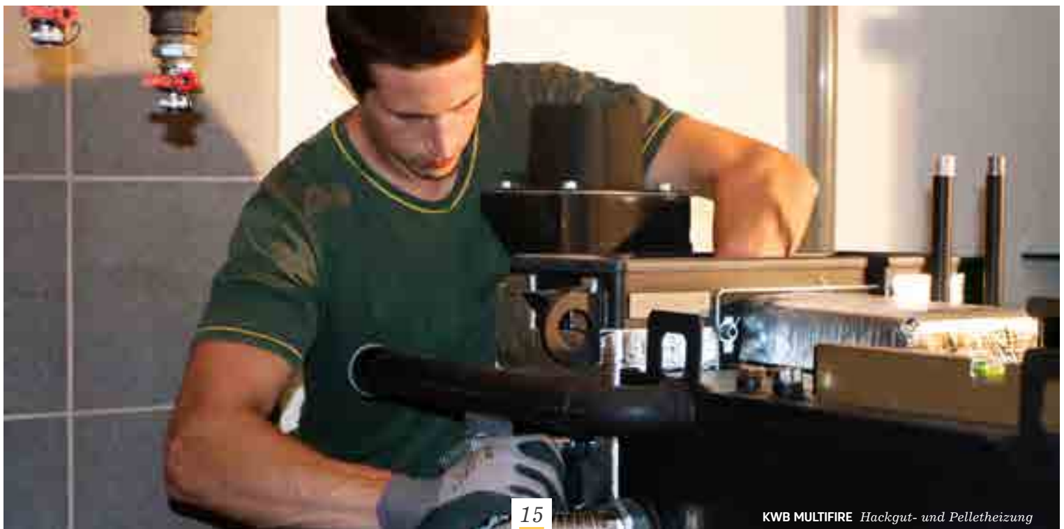
KWB Multifire – Kessel in 4 Teile zerlegbar
